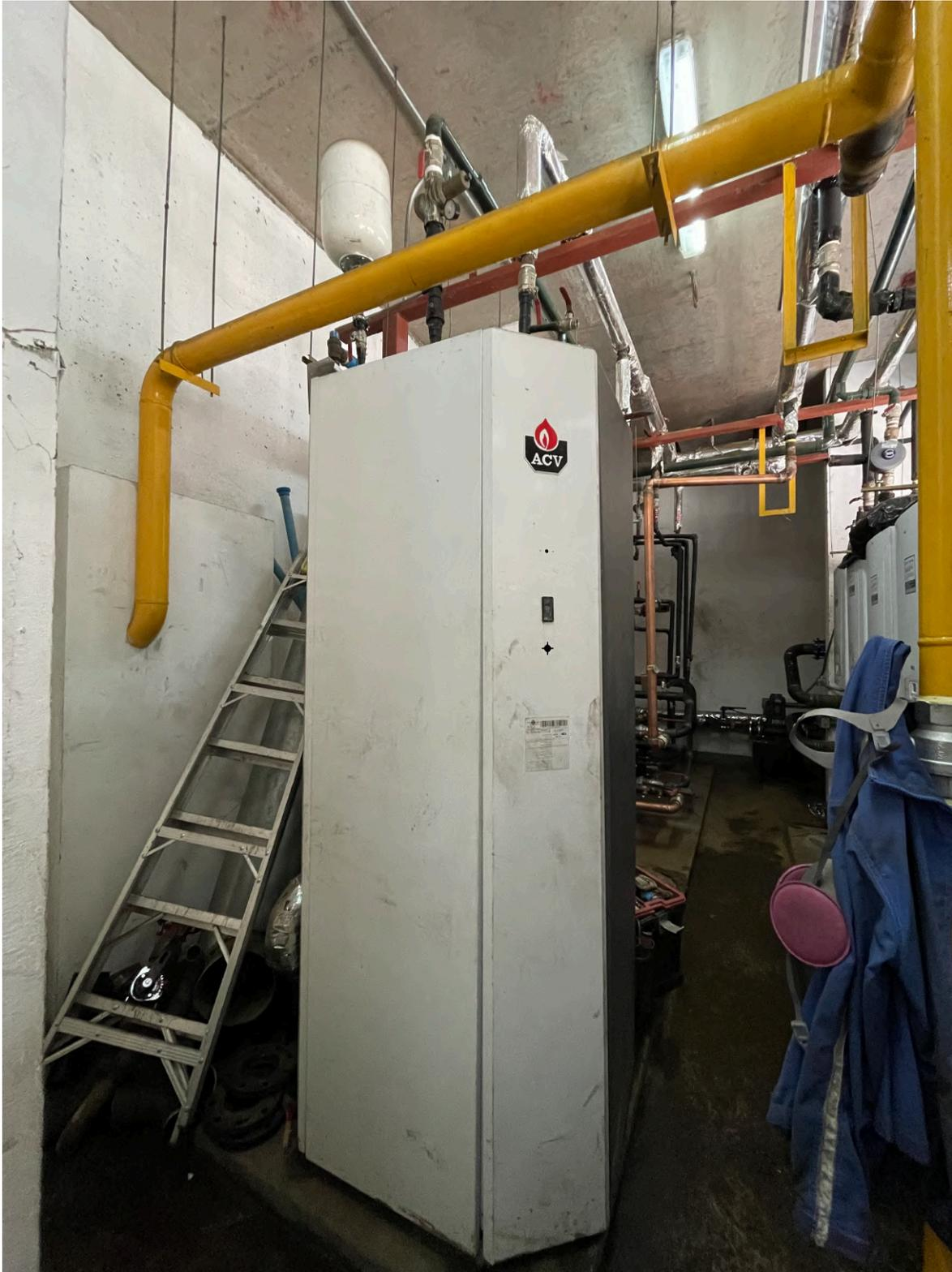
La instalación fue realizada de forma tan deficiente que, por ejemplo, los termómetros que deben ubicarse en las cañerías para medir la temperatura del agua que fluye por el sistema fueron colocados en tuberías que se ubican cercanas a los 4 metros de altura. Cada termómetro no supera los 10 centímetros de diámetro haciendo prácticamente imposible su lectura. En las siguientes imágenes es posible advertir esta situación:
